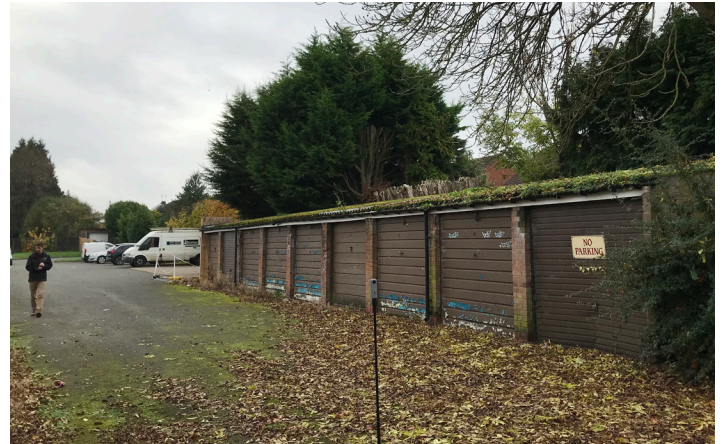
Site photographs (HLP)
